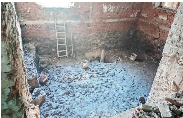
Рис. 1. Підвальне приміщення, над яким треба виконати перекриття
