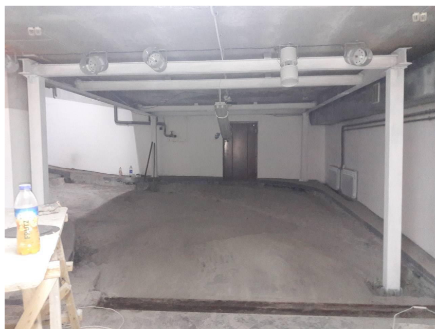
Рис. 6. Вигляд сталевих елементів посилення фрагменту плити
