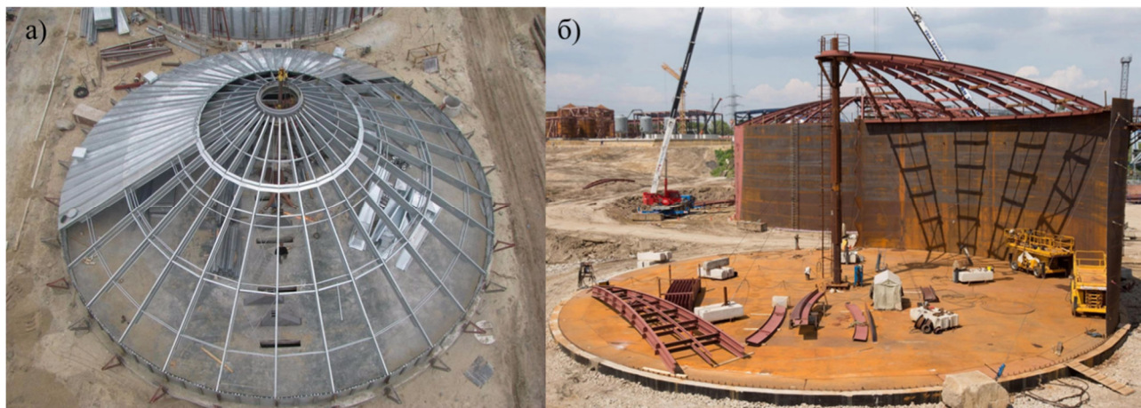
Рис. 1. Каркасна покрівля резервуару: а – конічна; б – сферична
