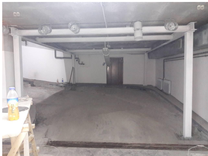
Рис. 6. Вигляд сталевих елементів посилення фрагменту плити
