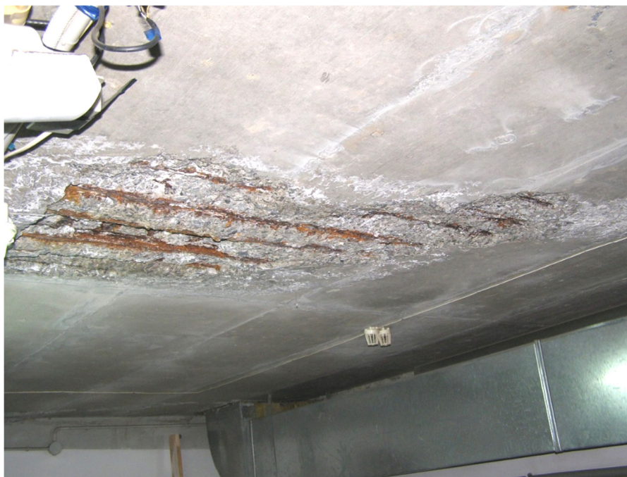
Рис. 3. Руйнування захисного шару бетону з оголенням та інтенсивним корозійним зносом арматури фрагмента плити в осях А-Б/8-9
